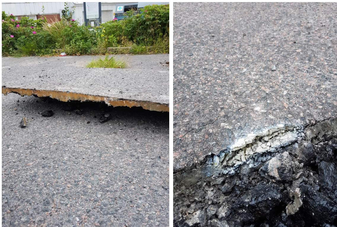
Figur 9-10. Tunna slitlager som underlagras av tjärad makadam i den norra delen av området.
